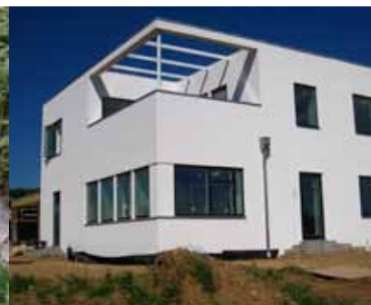
Lavenergi-byggeri - Comfort husene, Skibet
